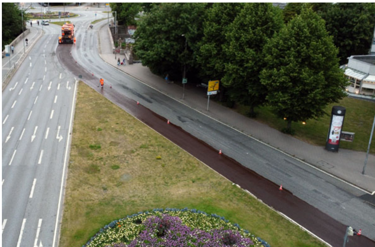
Noch bis in die Nacht zu Montag wird der Holstentorplatz saniert. Fotos: STE VG 16.07.2022 11.45
